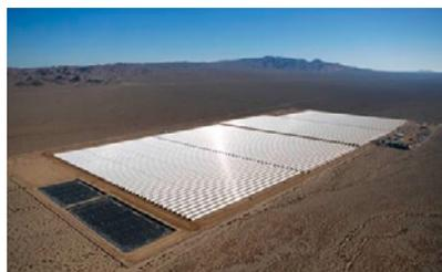
Die versilberten Spiegel von Nevada Solar One bei Boulder City, Nevada, leiten Sonnenlicht in ölgefüllte Rohre, um Dampf für eine Turbine zu erzeugen. So entsteht genügend Strom zur Versorgung von 14000 Haushalten.
